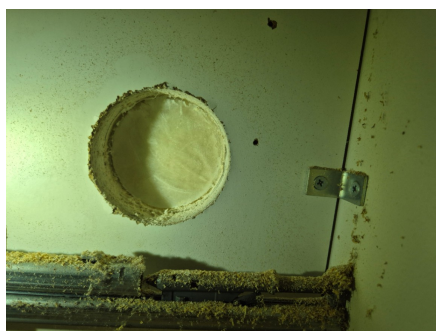
Dampsperre mot bad.
