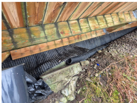
Vorteplast under terrasse.
