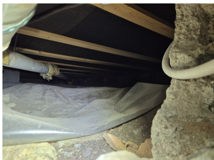
Krypkjeller sett fra kjellerbod.
