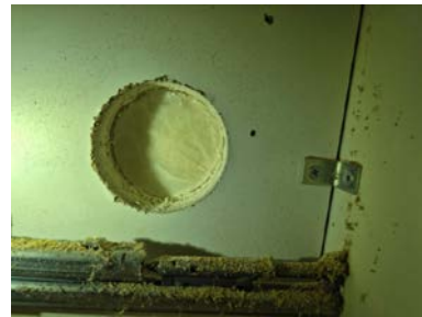
Dampsperre mot bad.
