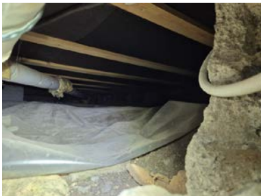
Krypkjeller sett fra kjellerbod.
