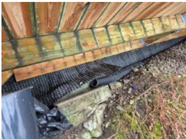
Vorteplast under terrasse.
