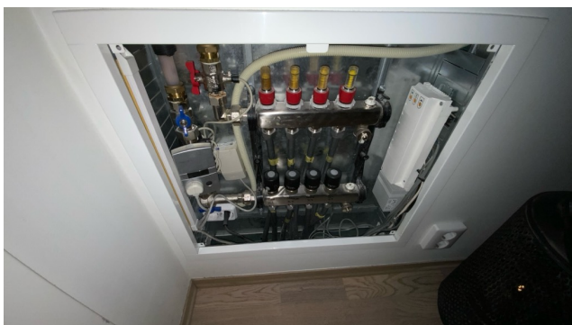
Besiktigelse av røropplegg.
