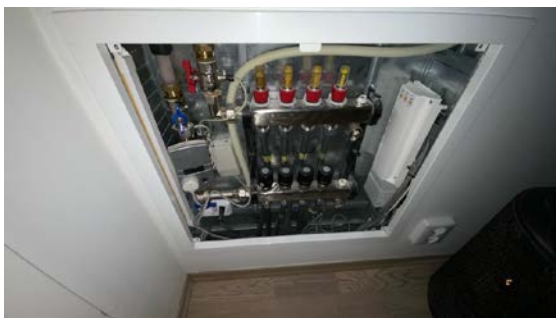
Besiktigelse av røropplegg.
