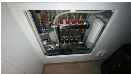
Besiktigelse av røropplegg.
