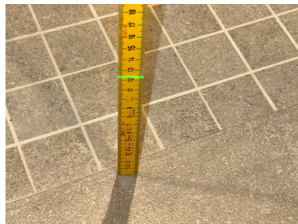
Fallforhold ca. 123 mm overkant gulv ved dusjsone
