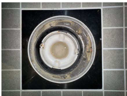
Plastsluk med klemring og synlig membran/mansjett
