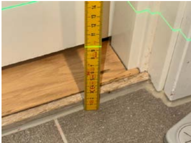
Fallforhold ca. 95 mm overkant gulv ved terskel
