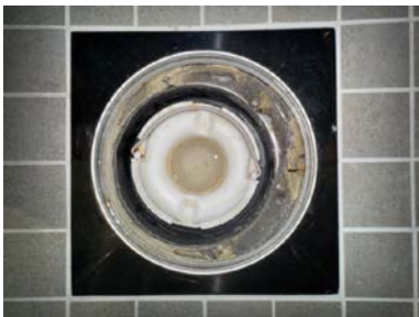
Plastsluk med klemring og synlig membran/mansjett
