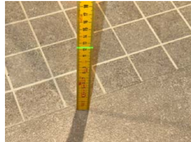
Fallforhold ca. 123 mm overkant gulv ved dusjsone
