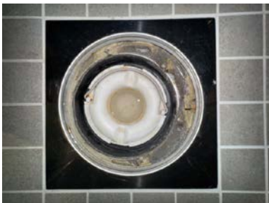
Plastsluk med klemring og synlig membran/mansjett
