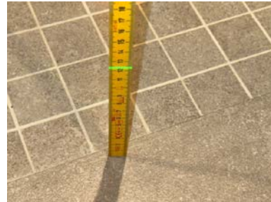
Fallforhold ca. 123 mm overkant gulv ved dusjsone
