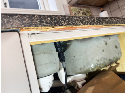
Fuktsvelling benkeplate
