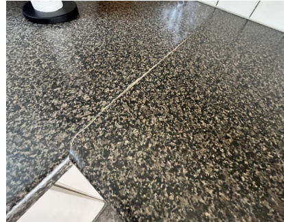
Fuktsvelling benkeplate
