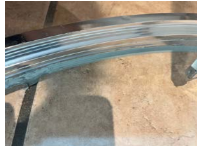
Skinne på gulv, fuget tett på innside i dusj.
