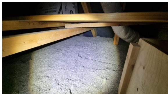
Loftskillet er isolert med innblåst isolasjon.
