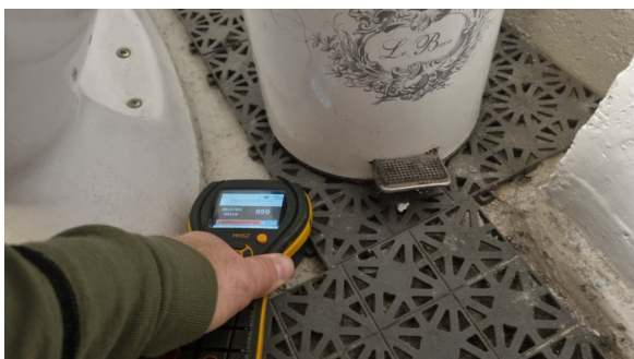
Fuktmåling i gulvet.
