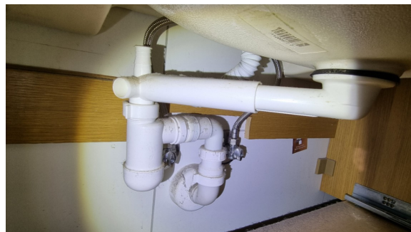
Kontroll av røropplegg under servanten.
