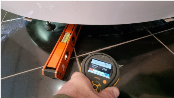
Fuktmåling og kontroll av fall mot sluk.
