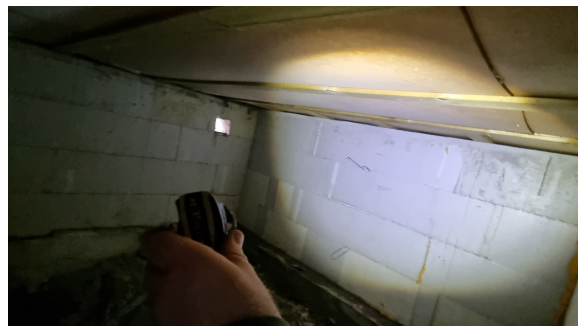
Inspeksjon av krypkjeller.
