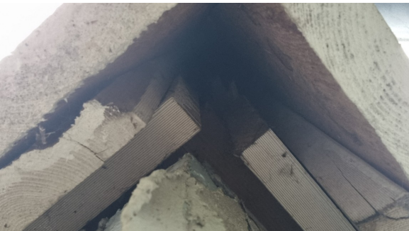
Kontroll av ytterkledningen.
