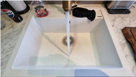
Kontroll av vanntrykk og avrenning.
