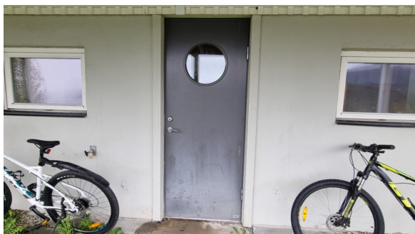
Inngangsdør i sokkeletasje.
