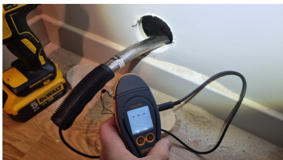
Hulltaking utført fra tilstøtende soverom.
