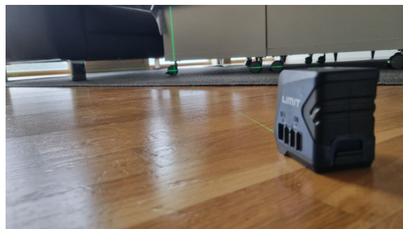
Kontroll av eventuelle skjevheter med krysslaser (hovedetasje).
