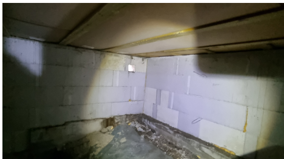
Inspeksjon av krypkjeller.
