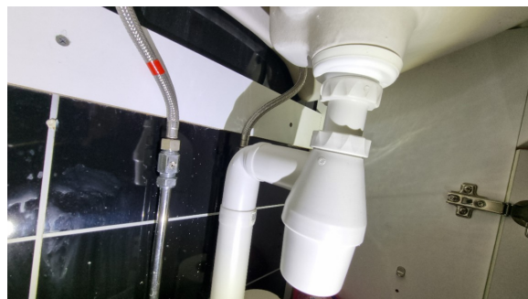
Kontroll av røropplegg under servanten.
