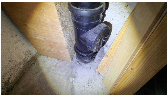
Stakepunkt på avløpsrør.
