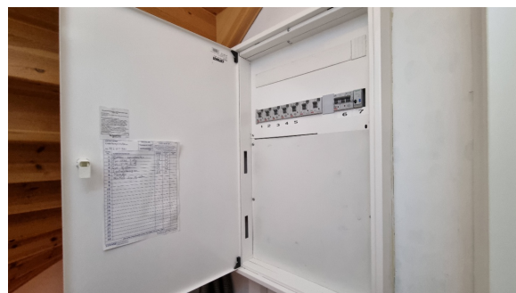
Kontroll av el-skapet øverst i trappeløpet mellom sokketasje og hovedetasje.
