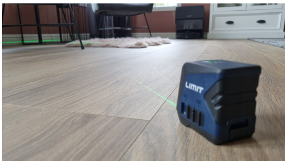
Kontroll av eventuelle skjevheter med krysslaser (hovedetasje).
