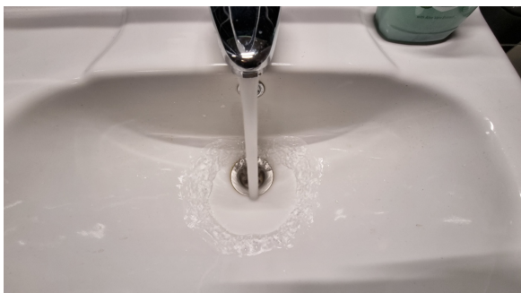
Kontroll av vanntrykk og avrenning.
