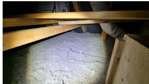
Loftskillet er isolert med innblåst isolasjon.
