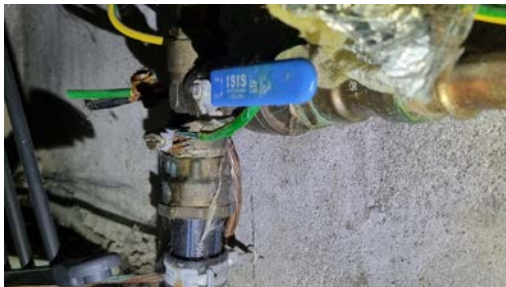
Kontroll av innvendig hovedstoppekran.
