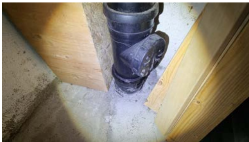
Stakepunkt på avløpsrør.
