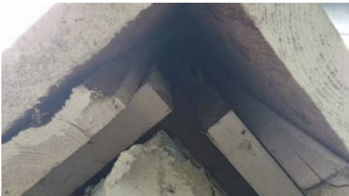
Kontroll av ytterkledningen.
