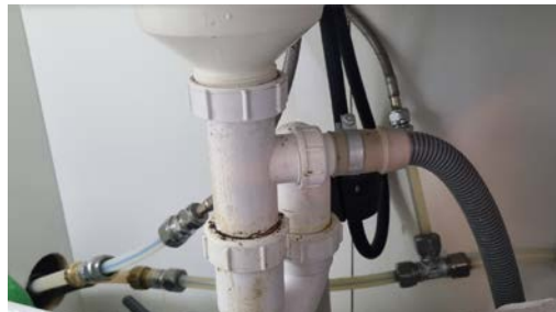
Kontroll av røropplegg under oppvaskkummen.
