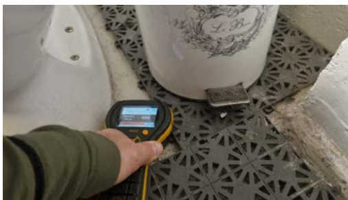
Fuktmåling i gulvet.
