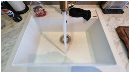
Kontroll av vanntrykk og avrenning.
