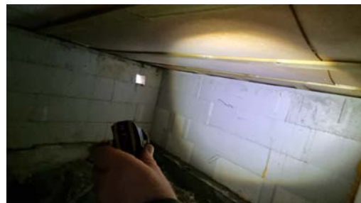
Inspeksjon av krypkjeller.
