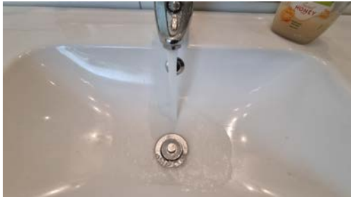
Kontroll av vanntrykk og avrenning.
