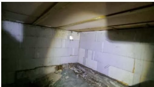
Inspeksjon av krypkjeller.
