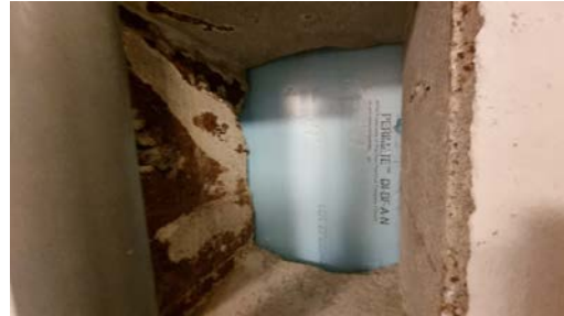
Ved et hull i yttervegg i sokkeletasjen ser man rett på styrofoamplate som er lagt på utsiden av grunnmuren.
