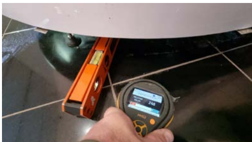
Fuktmåling og kontroll av fall mot sluk.
