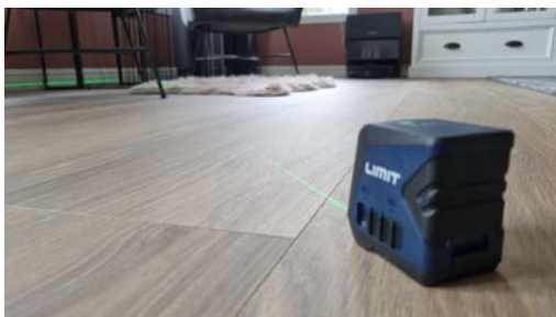
Kontroll av eventuelle skjevheter med krysslaser (hovedetasje).
