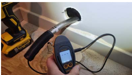
Hulltaking utført fra tilstøtende soverom.
