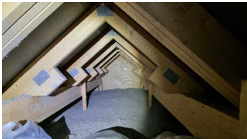
Inspeksjon av kaldloftet
