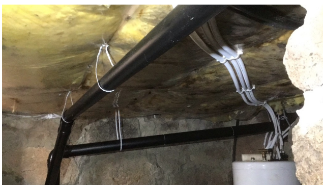
udekket isolasjon i tak
