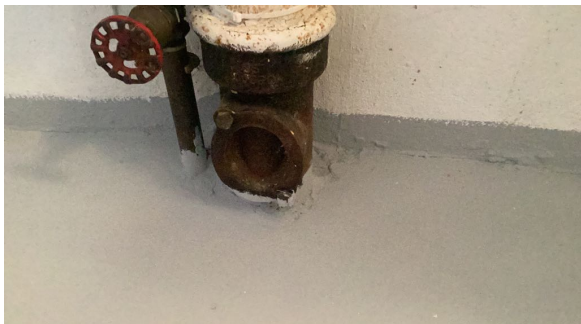
Stakepunkt i vaskekjeller.
