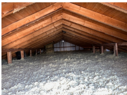
Oversiktsbilde av loft.
