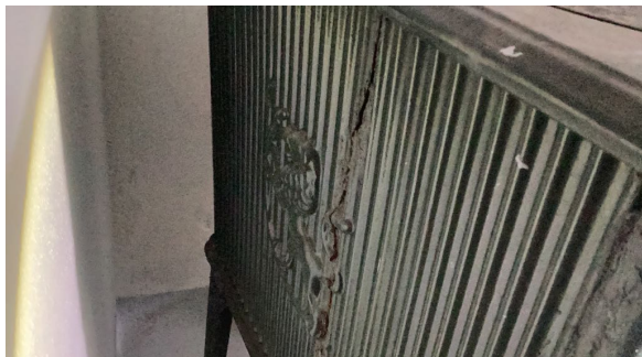
Sprekk i sidevegg på vedovn i kjeller.
