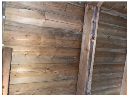
Eksempel på svertesopp på undersiden av taktro.
