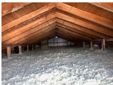
Oversiktsbilde av loft.
