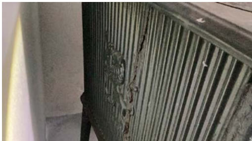
Sprekk i sidevegg på vedovn i kjeller.
