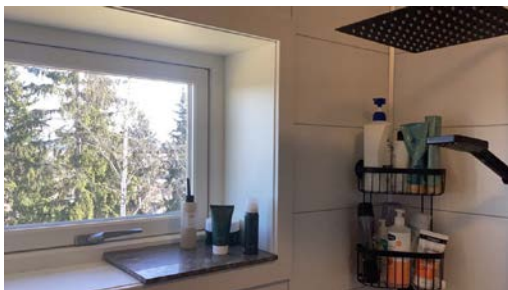
Det er vindu i våtsone i dusj.
