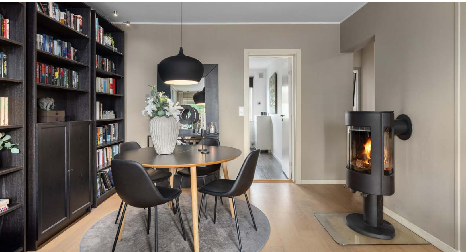
Det er montert ny peisovn i 2016 og pipeløp ble rehabilitert i regi av borettslaget i 2020.
