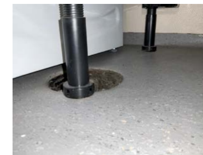
Plast sluk i gulv.
