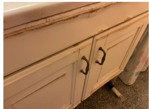
Fuktsvelling på baderomsinnredning.
