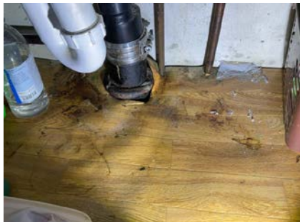
Fuktskade og fukt i benkeskap.
