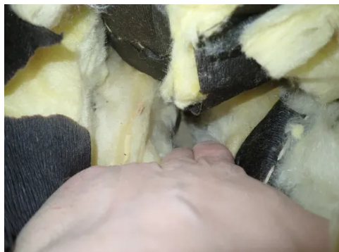
Besiktigelse ned rundt avtreksventil fra loft.
