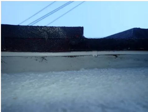
Oversiktsbilde oppunder kledning.
