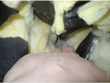
Besiktigelse ned rundt avtreksksventil fra loft.
