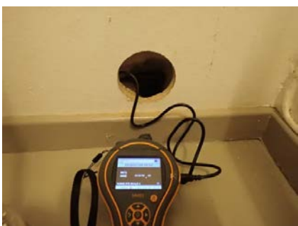
Hulltakingen viser ingen fukt eller skader i treverk i borehullet.
