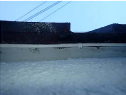
Oversiktsbilde oppunder kledning.
