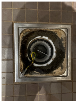
Stålsluk med klemring for membran
