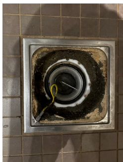
Stålsluk med klemring for membran
