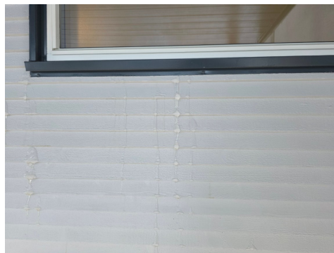
Isdannelse som kommer fra underkant av baderomsvind
