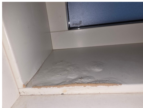
Fuktskadet utforing på bad
