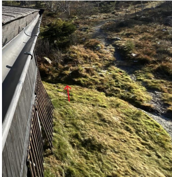
Avskjæringsgrøft på øst side
