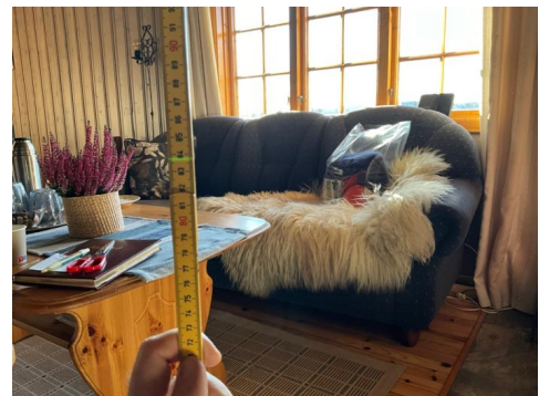
Måling av planavvik. Laserstrek viser 838mm.
