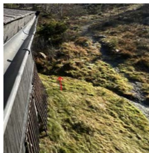
Avskjæringsgrøft på øst side
