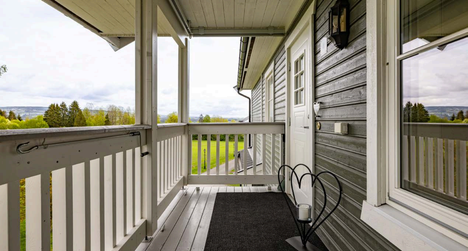
Hyggelig overbygget inngangsparti med en terrasse på ca. 6m 2 . Det er montert utebelysning, stikkontakt og ringeklokke på vegg.
