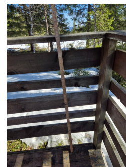
Lavt rekkverk på terrasse mot syd.
