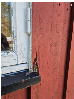
Råteskader i over- og underligger.
