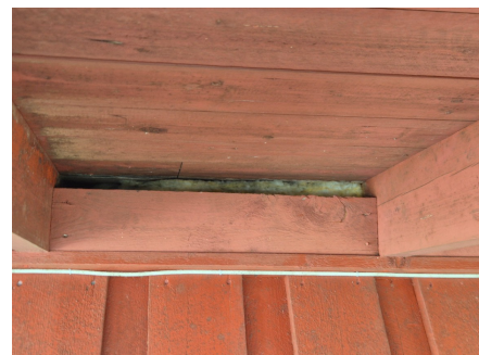
Synlig isolasjon i luftespalte.
