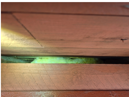
Synlig isolasjon i luftespalte.
