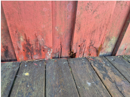
Råteskader i over- og underligger.
