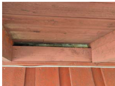
Synlig isolasjon i luftespalte.
