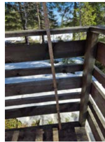
Lavt rekkverk på terrasse mot syd.
