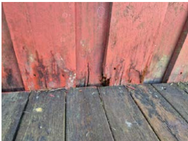
Råteskader i over- og underligger.
