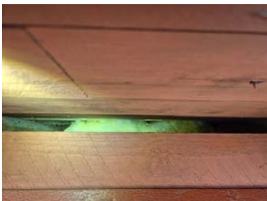
Synlig isolasjon i luftespalte.
