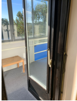
Balkongdør med malt treramme
