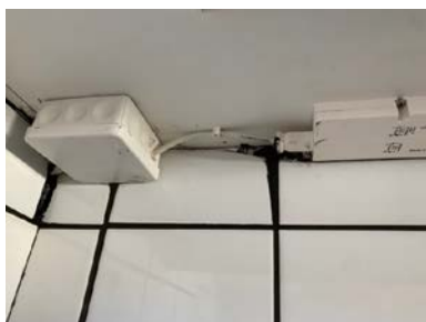
Lampettledning tilkoblet koblisnboks
