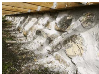
Grunnmur mot sør er restaurert.
