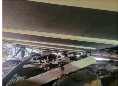
Stubbtele er kledd med asfaltplater.
