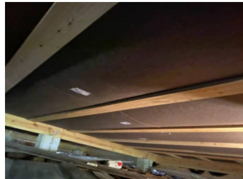
Stubbtele er kledd med asfaltplater.
