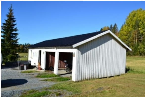
Garasje Innkjøring på sydvegg.
