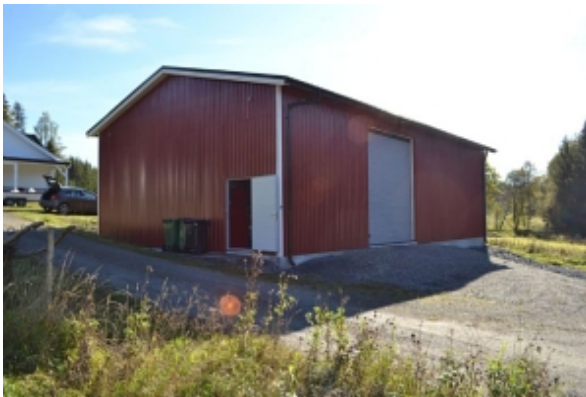
Vognskjul/verksted Inngang på nordvegg. Port på vestvegg
