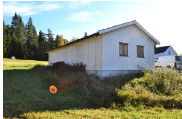
Garasje Vest og nordvegg
