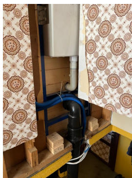
Åpen vegg i kjellernedgang mot toalettsistene.
