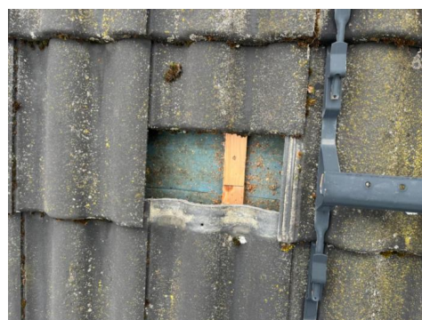
Takstein med duk som undertak.
