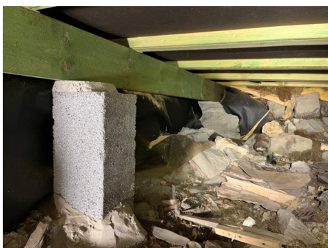
Krypkjeller vest med oppgradert bjelkelag.
