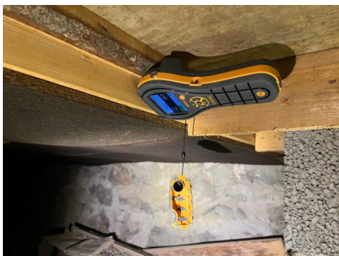
Fuktmåling i trevirke viste ca. 10 %, som er normalt.
