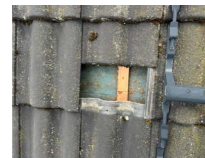
Takstein med duk som undertak.
