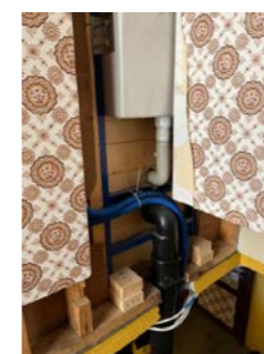
Åpen vegg i kjellernedgang mot toalettsisterne.
