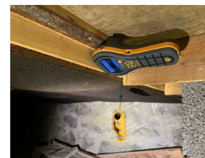
Fuktmåling i trevirke viste ca. 10 %, som er normalt.
