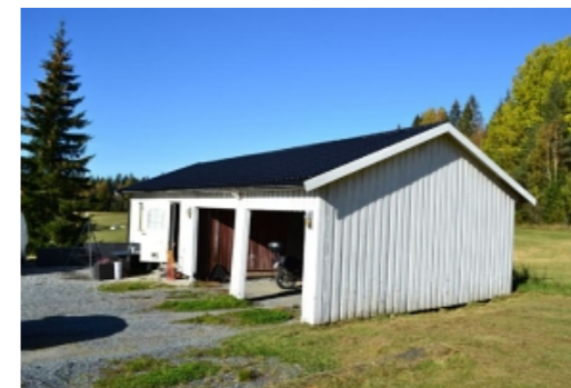
Garasje Innkjøring på sydvegg.
