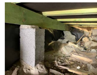
Krypkjeller vest med oppgradert bjelkelag.
