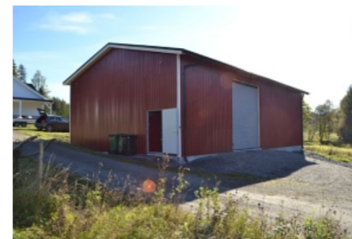
Vognskjul/verksted Inngang på nordvegg. Port på vestvegg
