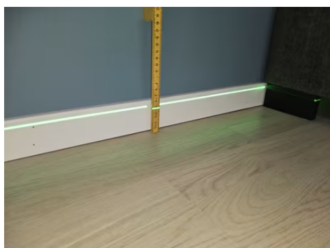
Etasjeskille er kontrollert med nivelleringslaser.
