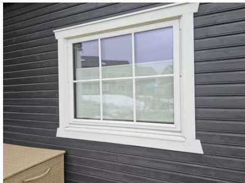
Vinduer med karm av tre og tre-lags glass.
