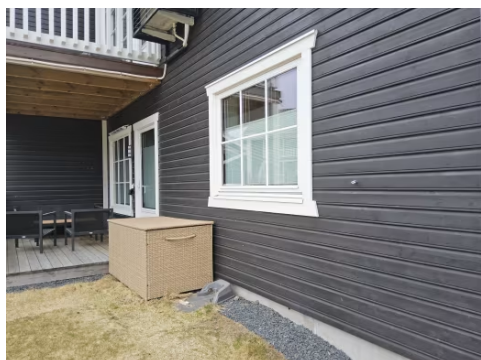
Yttervegger er kledd med liggende kledning.
