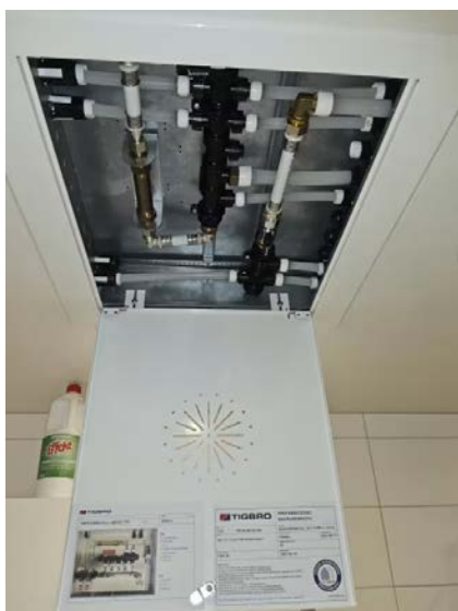
Fordelerskap for rør-i-rør er plassert i himling på bad.
