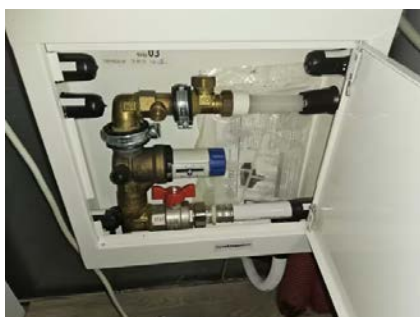
Fordelerskap for rør-i-rør er plassert i himling på bad.
