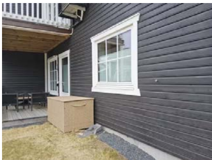
Yttervegger er kledd med liggende kledning.
