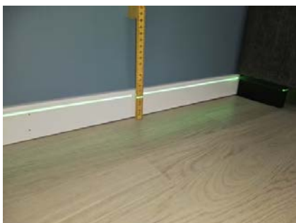
Etasjeskille er kontrollert med nivelleringslaser.
