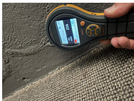
Måles fukt i murvegg kjellerstue.
