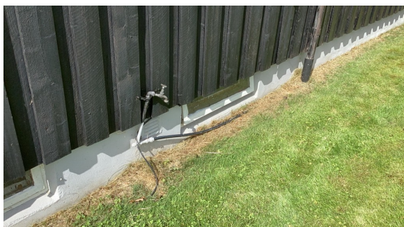
Gammel utekran med utvendig skjøterør til utekran foran huset.
