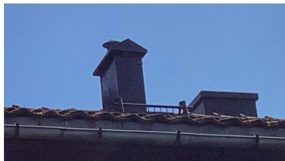
Nyere takhatt på lufterør.
