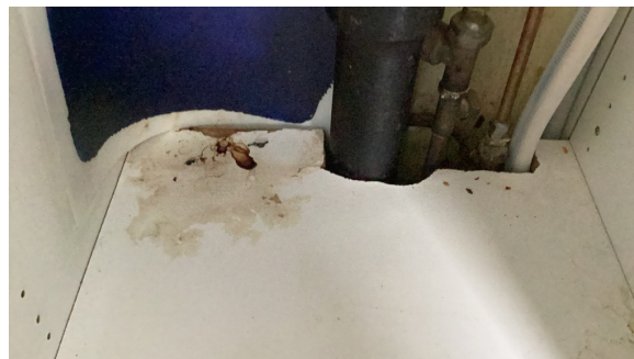
Fuktskjolder i servantskap.
