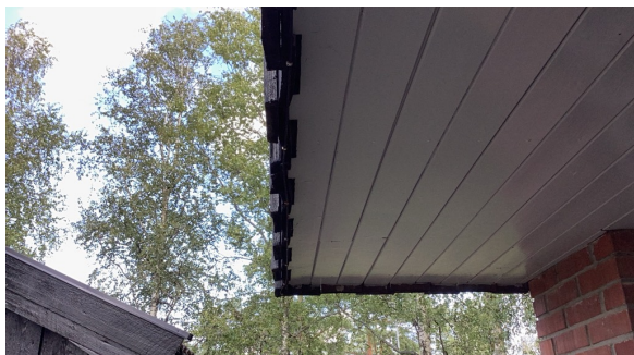
Lite luft bak kledning.
