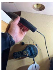
Måles ingen fukt i gulv bak dusjkabinett.
