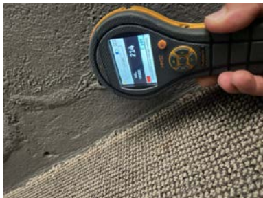
Måles fukt i murvegg kjellerstue.
