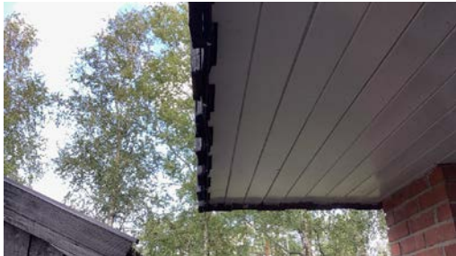
Lite luft bak kledning.
