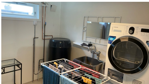
Oversiktsbilde av bad.
