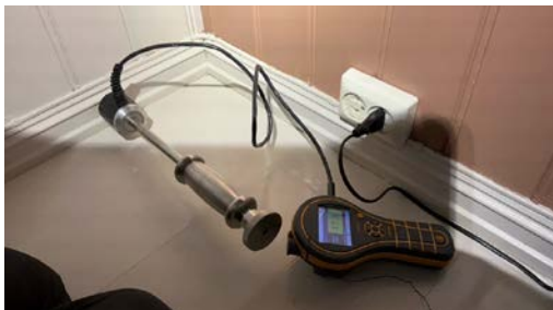
Fuktmåling med hammerelektrode registrerte jeg risikable verdier for fukt.
