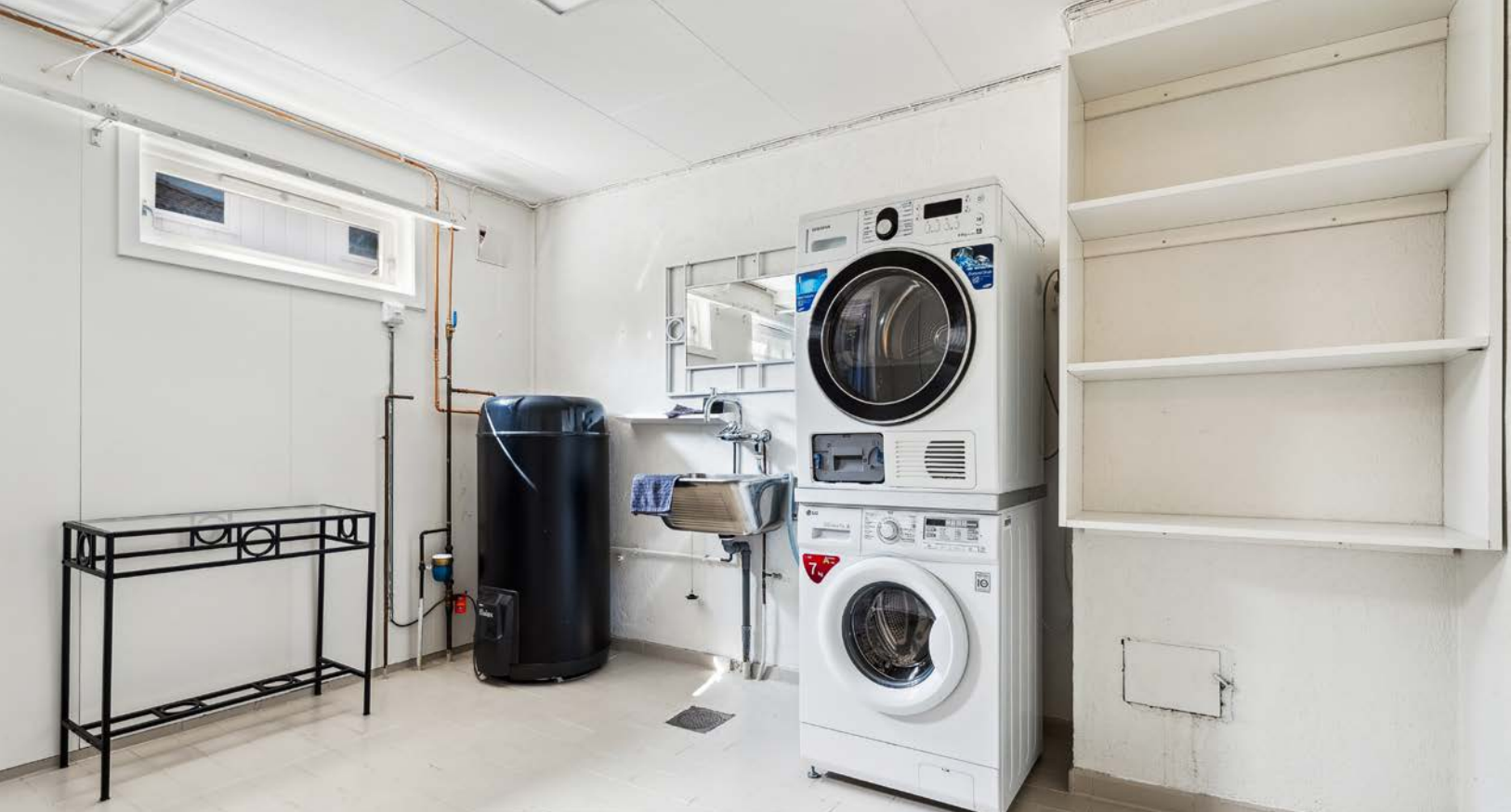
Vaskerom med opplegg for vaskemaskin og tørketrommel.
