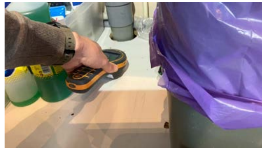
Noe svelling i bunnplate under servant. Fuktsøk viste normale verdier.
