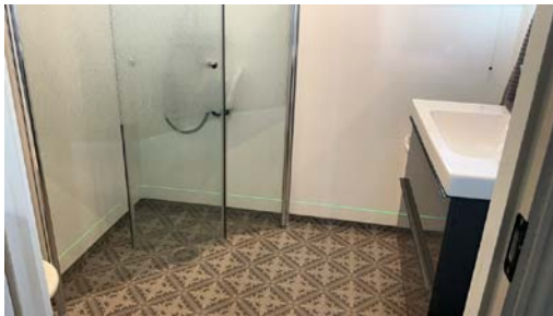
Oversiktsbilde av bad.
