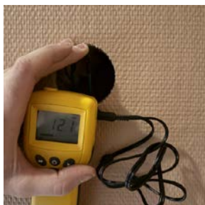
Hulltaking i trappeåpning for bad 2 etg.
