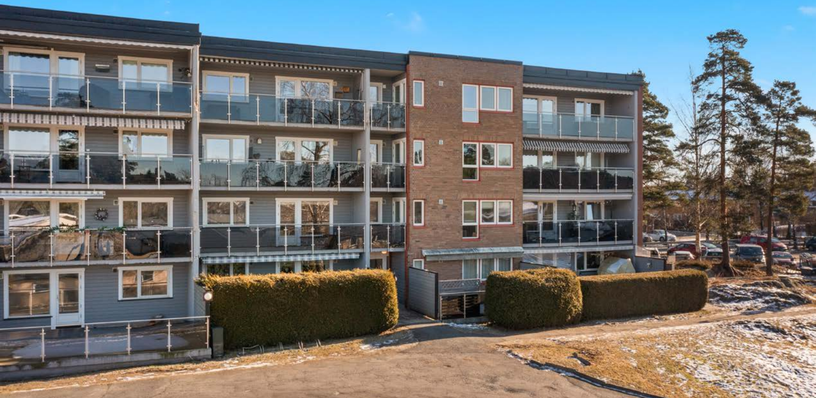
Leiligheten ligger i tredje etasje.
