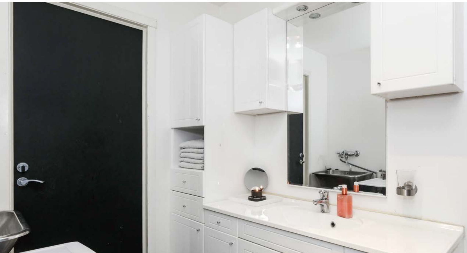
Rommet er utstyrt med dusjkabinett, toalett, skyllekar, rør og baderomsmøbel, samt mekanisk avtrekk til felles kanal.
