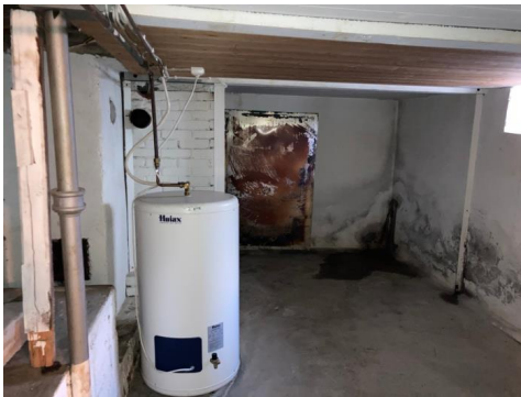
Bereder for loftetasje.
