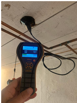
Ved fuktmåling i bjelkelag ble det målt ca. 10 %, som er normalt.
