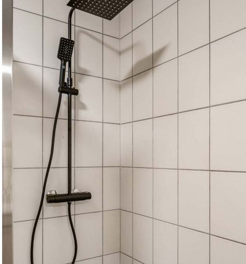
Dusjhjørne med vegg av glassbyggerstein og sort armatur fra 2024 med både hånd- og regnfallsdusj.
