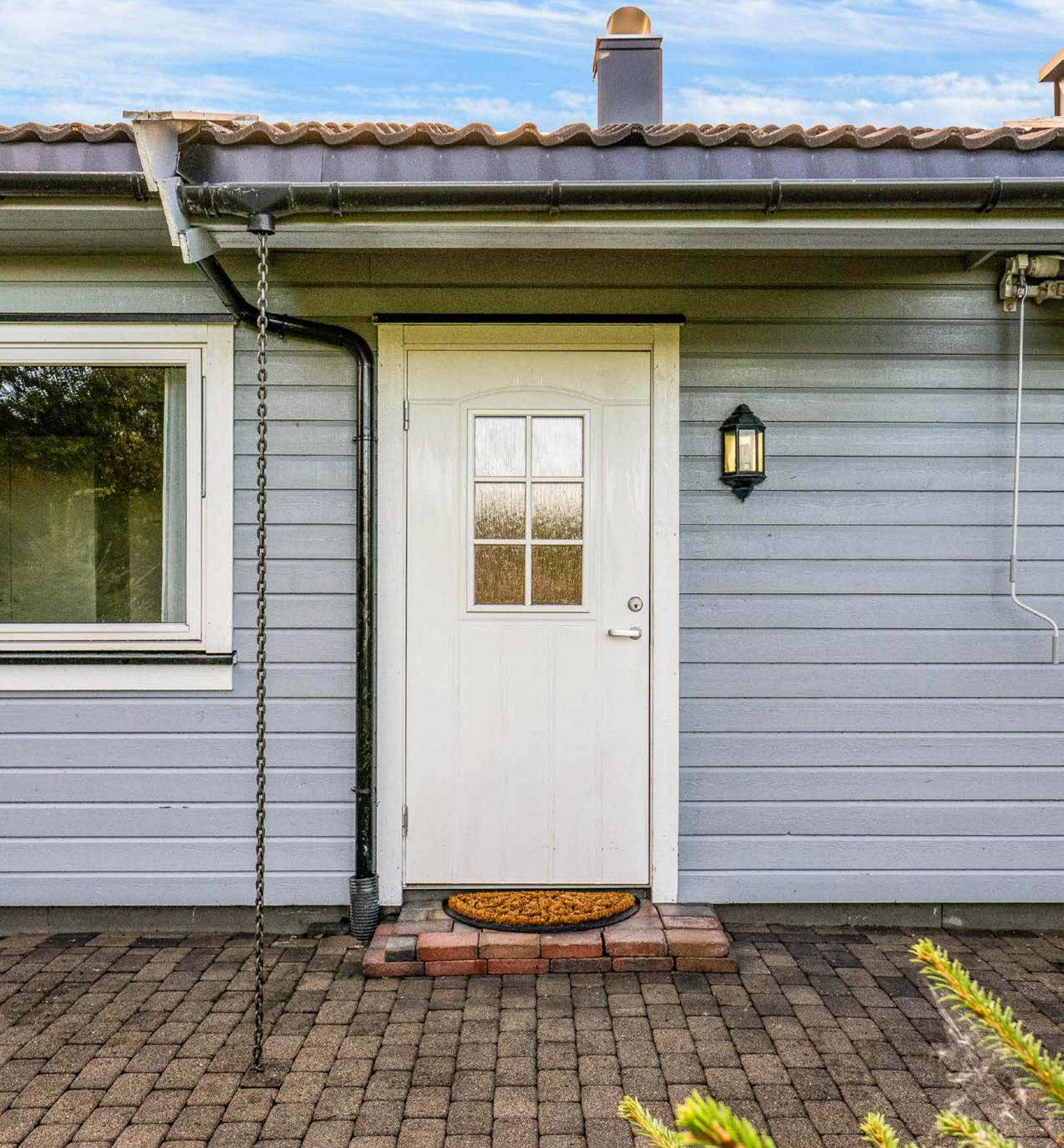
Praktisk med takoverbygg og utebelysning ved inngangsdøren.
