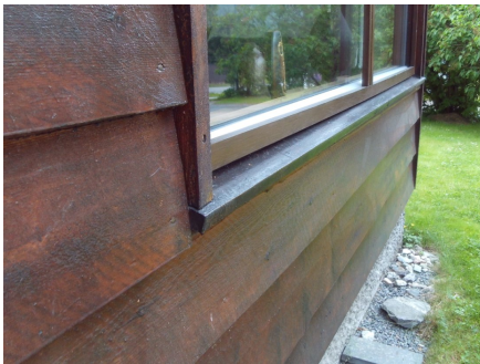
Deler av kledningen med tilhørende belistninger
