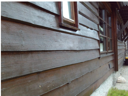
Deler av kledningen med tilhørende belistninger
