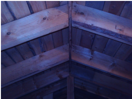
Deler av kaldtloftet over garasje.
