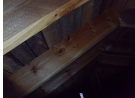
Sperrekonstruksjon med bord som undertak.
