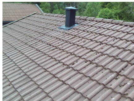
Tekkingen har normal slitasje
