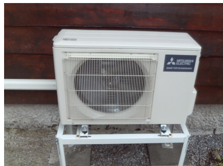
Ytterdelen er nylig blitt byttet
