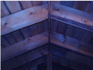
Deler av kaldtloftet over garasje.
