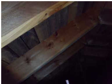
Sperrekonstruksjon med bord som undertak.
