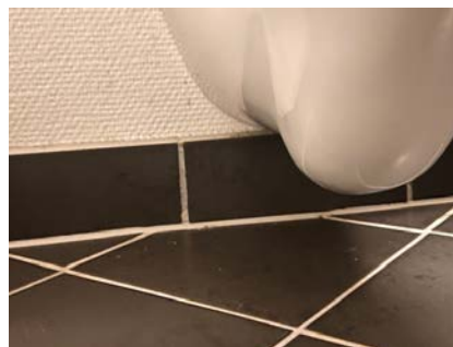
Ingen synlig lekkasje varsler under toalett
