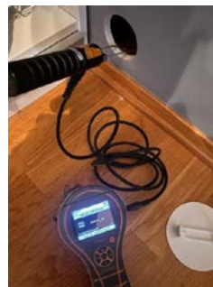
Fuktmåling i vegg mot våtsone.
